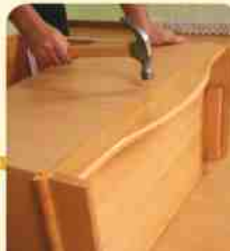
8. Закрепите на собранной конструкции заднюю стенку
