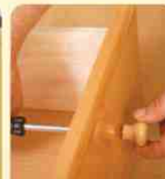
18. Прикрепите ручку к фасаду саморезом 4x40
