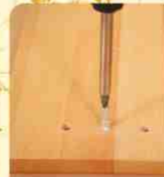
12. Вкрутите винт эксцентрика в фасад ящика
